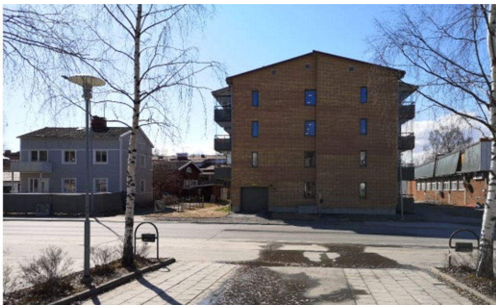
Figur 4. Fotot är taget från Guldskrinet 1 – fastigheten som är belägen öster om Rothoffsvägen. Till vänster i bild ett tvåbostadshus uppfört 1939 inom Bytesgården 7 (röd ring i Figur 3). Mitterst syns ett nybyggt flerbostadshus i fyra våningsplan som är uppfört inom nuvarande fastighet Bytesgården 12 och till höger i bild skymtas del av den industribyggnad som tidigare var belägen inom det aktuella planområdet, men revs 2021.
