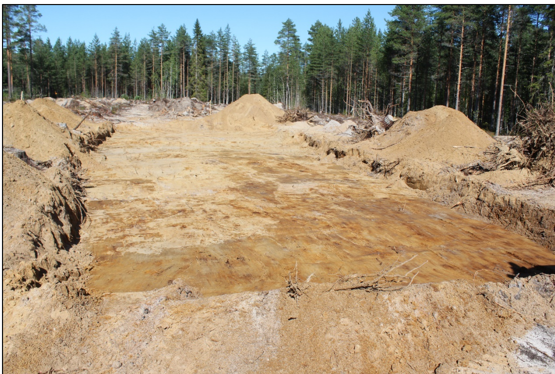
Figur 11. Djupschaktning genomfördes efter att de tre aktivitetsytorna undersökts och borttagits. Syftet var att kontrollera så att ingen översandning förekommit.
