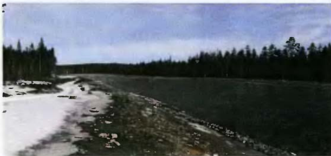
Området avgränsas i nordost av den nya järnvägen som är under byggande.
