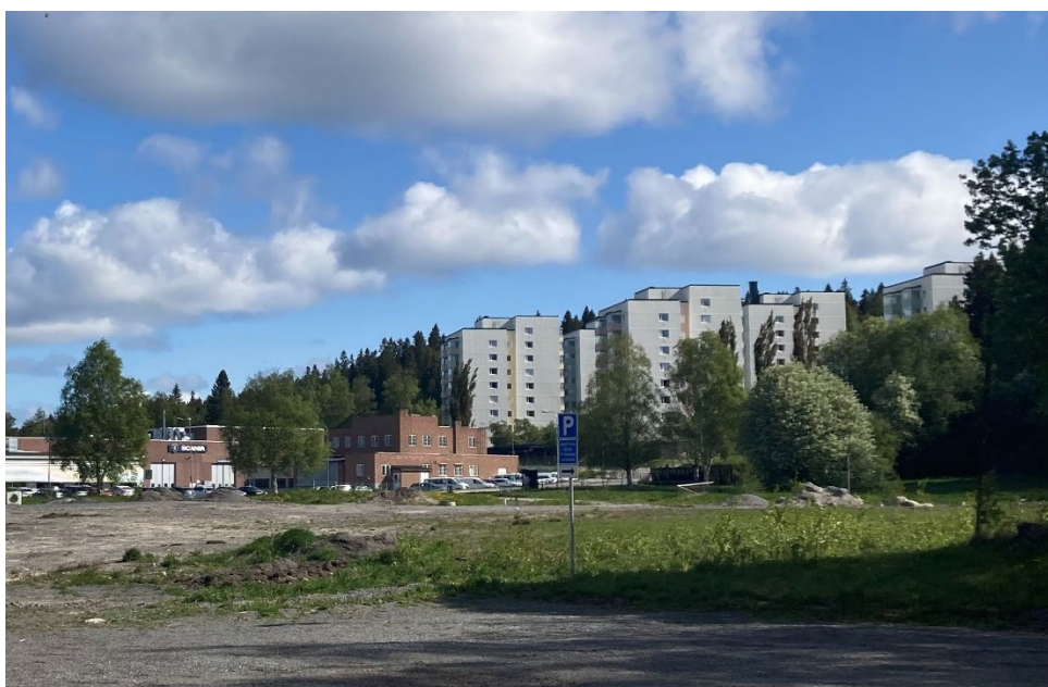
Figur 6. Punkthus i skogsbrynet upp mot Stadsliden, i förgrunden syns Syrgasfabriken. Fotot är taget från planområdet för kvarteret Guldskrinet.
