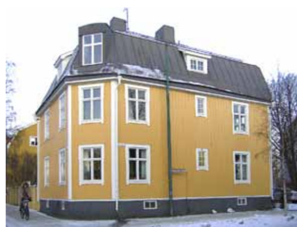
Falken 1, Nytorgsgatan 14/Ö Norrlandsgatan. C A Sandström 1920.
