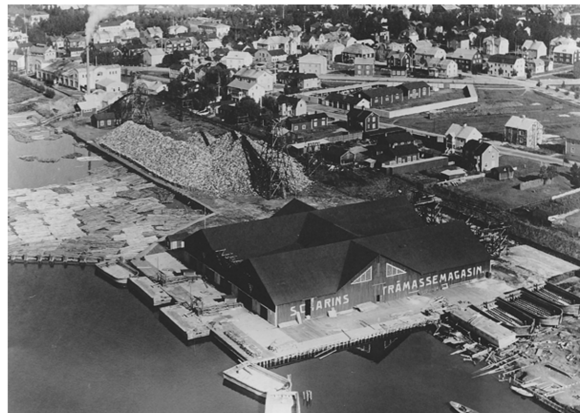
Scharinska fabriken område på Öbacka. Träsliperibyggnaden längst upp till vänster.
