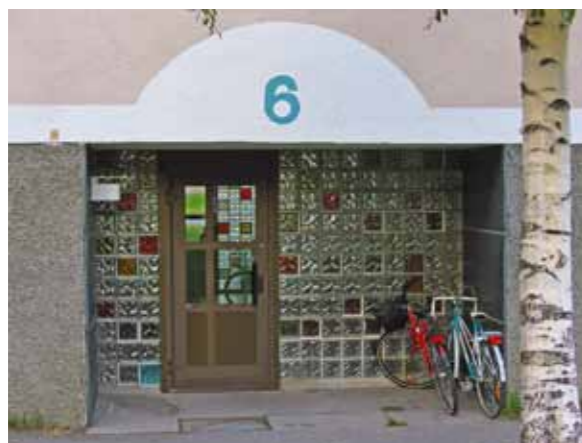
Entréparti med vägg i glasbetong.
