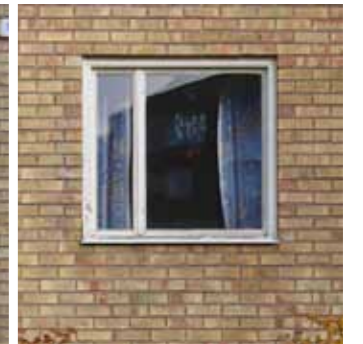
1960-tal. Sidoställd mittpost. Smalt vädringsfönster.
