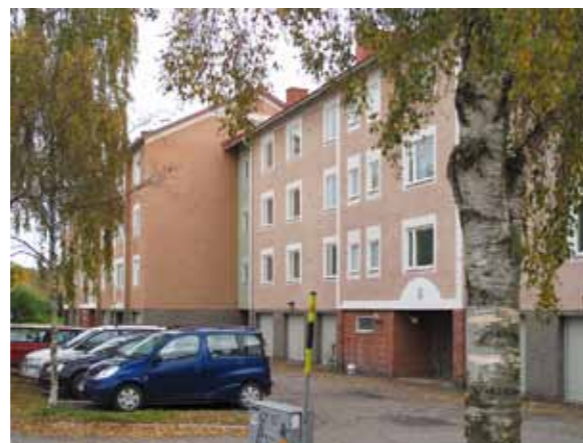
Utsidan mot järnvägen i nordväst.
