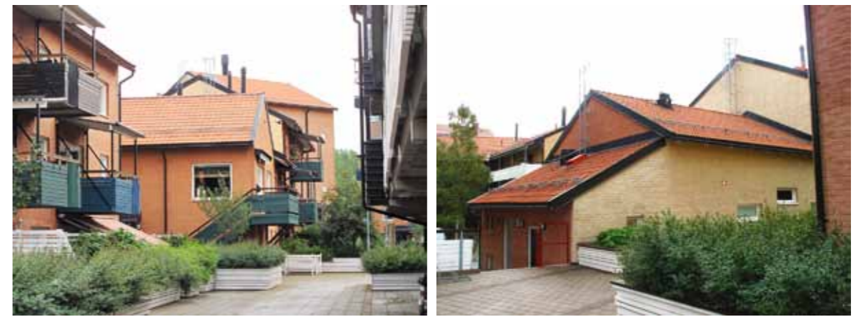
Slammade tegelfasader som byter färg över hörnet, sadeltak med tvåkupiga betongpannor och svarta plåtarbeten.
