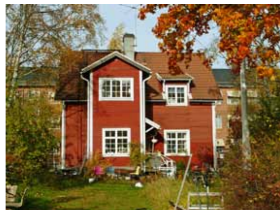
Nytt entréparti och ny takkupa på egnahem från 1920-talet.
