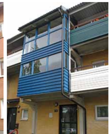
Senare tillkommen brandcell i plåt och glas utanför trapphusen.
