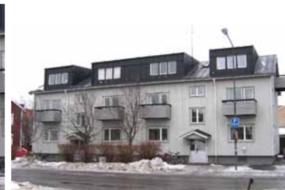
Ärlan 5, Hamrinsvägen 3 med överstora takkupor.
