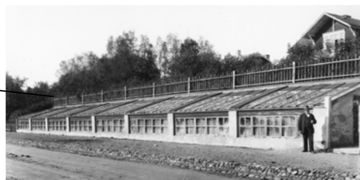
Växthus vid Östra Strandgatan, i nedre änden av kvarteret Älvsbacka.
