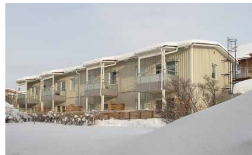
Hunden 25, Storgatan 112–114. Gårdshus med uteplatser mot granntomten i söder. Början av 2000-talet.
