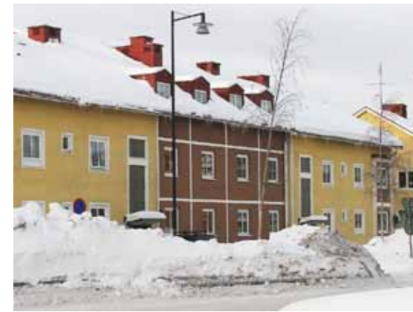
Hunden 25, Storgatan 112–114, med för 50-talet och arkitekten typisk fasad. Tyvärr har fönstren i sen tid bytts ut mot mindre skinsticksfönster. J D Sundbergs arkitektkontor, Hillevi Callander.
