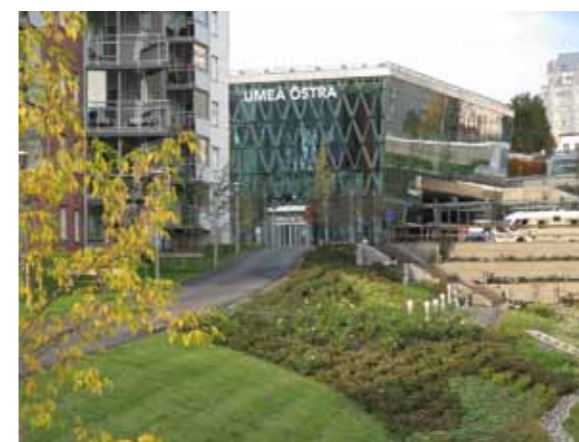
Del av den nya stationsparken som sträcker sig ned mot älven.
