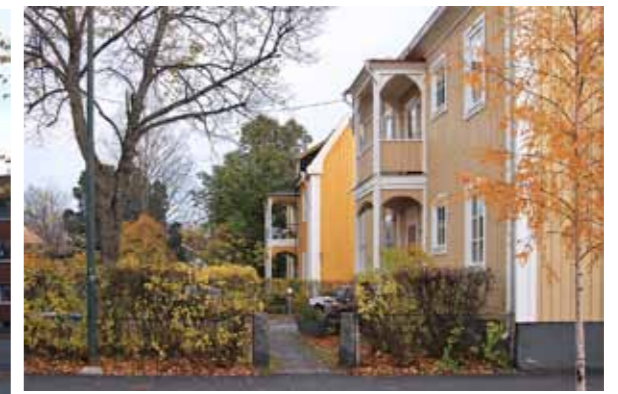
Ekorren 7 och 8 med karaktäristiska tvåvåningsverandor.
