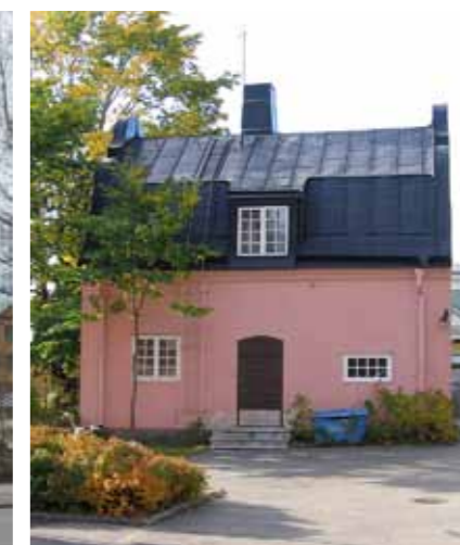
Stallbyggnad, ursprungligen med tre spiltor, vagnbod, höskulle och kuskbostad. Ragnar Östberg 1905.
