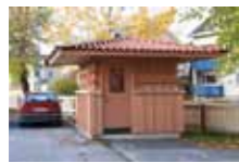
Transformatorstation med ambitiös utformning.
