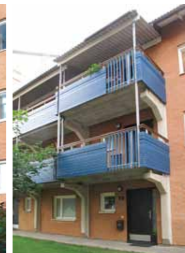
Ursprungligt utförande av loftgång utanför trapphus.
