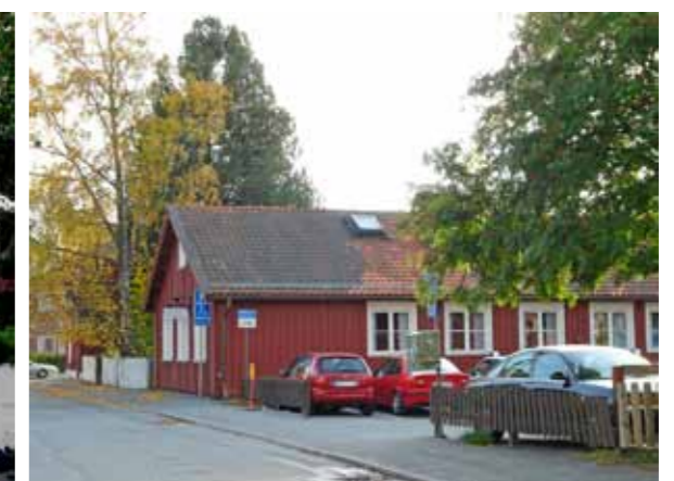
Ripan 3. Gårdshus med kontorslokaler utmed brandgatan. 1963.
