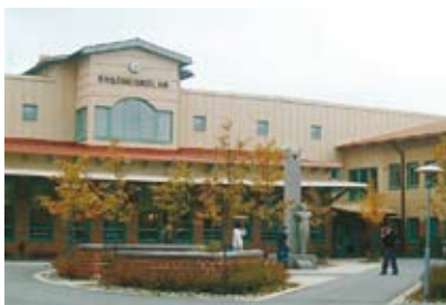
3. Ersängsskolan, LM-skola och fritidshem. VBB, Sten Ehnberg och Katrin Ehnberg-Gunnarsson, 1989. Ostsvägen 20.
