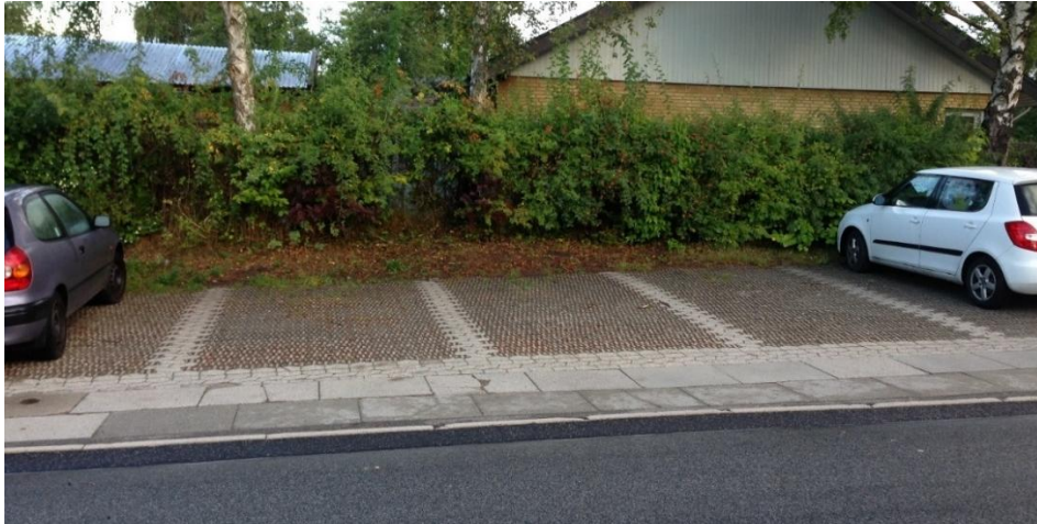
Figur 33. I figuren presenteras ett förslag på hur en genomsläpplig parkeringsyta kan utformas för att möjliggöra infiltration av dagvatten (WSP, 2019).
