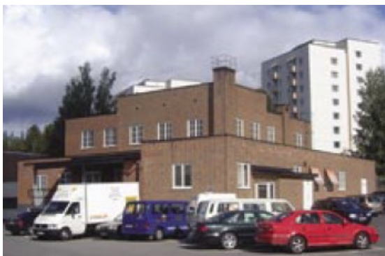
Figur 4 bevarandevärd byggnad inom Verkstaden 18
