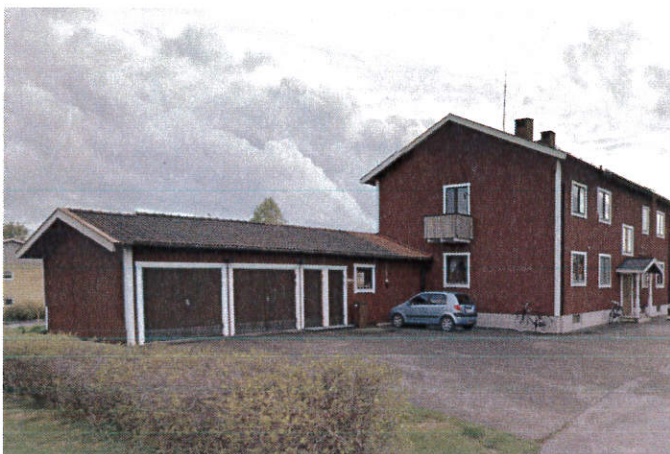
Garaget som sökande har för avsikt att riva.
