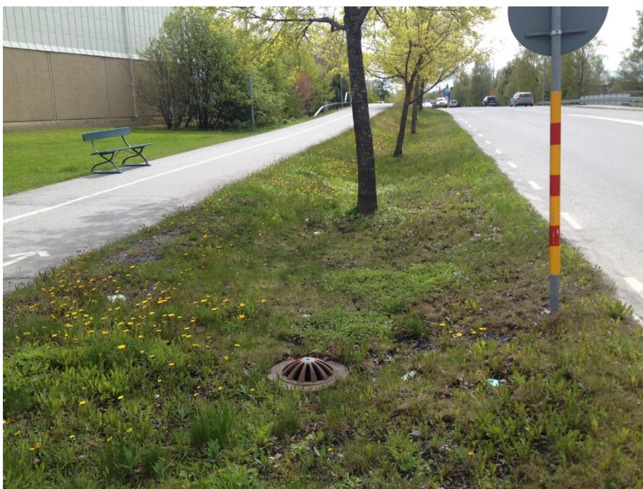
Figur 13. Exempel på svackdike i Östersund. Svackdiket avslutas i en kupolbrunn, men en helt öppen avledning är också möjlig. Foto: Rickard Olofsson, Sweco.
