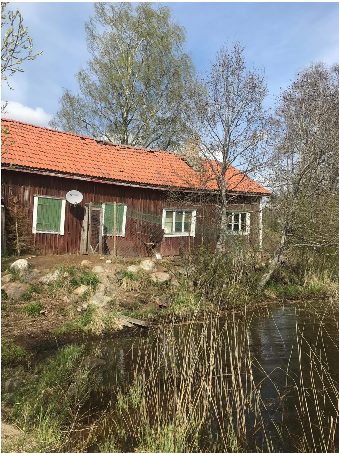
Bild 2 Bild tagen från befintlig pir med befintlig byggnad och strandkant.
