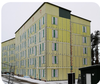
Under 2018 byggdes det över 300 studentbostäder på Tvistevägen
